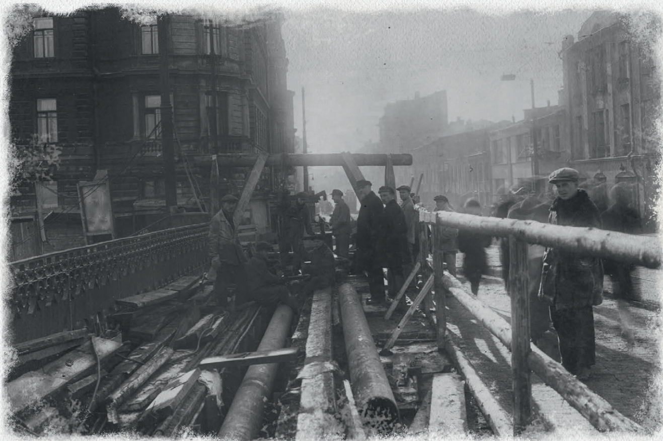
Монтаж тепломагистрали на Малом Москворецком мосту, 30-е гг. XX века
