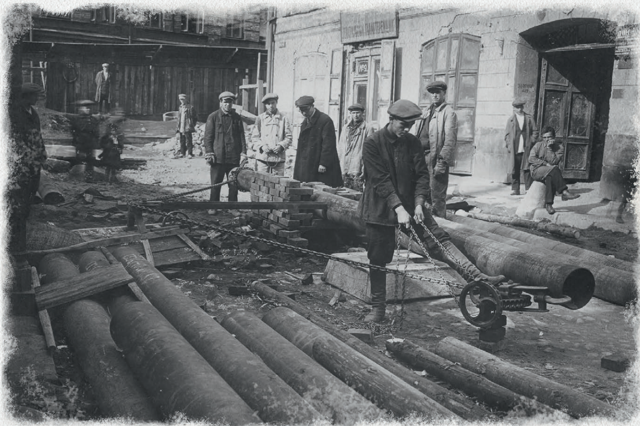
Изгиб труб перед укладкой. Москва, Зарядье, 30-е гг. XX века
